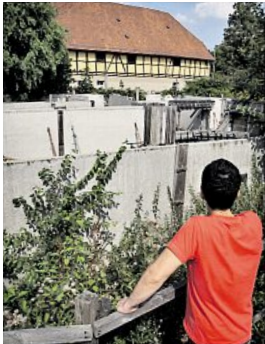
Noch sieht's so aus: Die Ruine in der Hoffmann-von-Fallersleben-Straße. Photowerk (mv)
